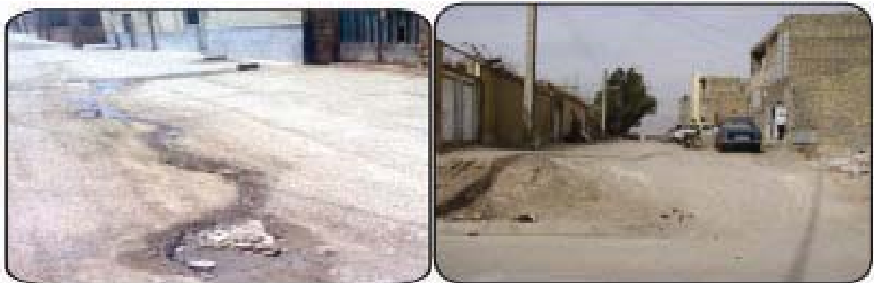
شکل شماره ۳- وضعیت نامناسب دفع فاضلاب و وجود معابر و کوچه های خاکی در محله حسن آباد شهر یزد (اسفند ۱۳۸۷)
